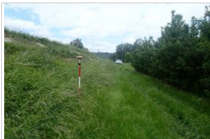
Berge rive droite - Photo ©AGERIN
