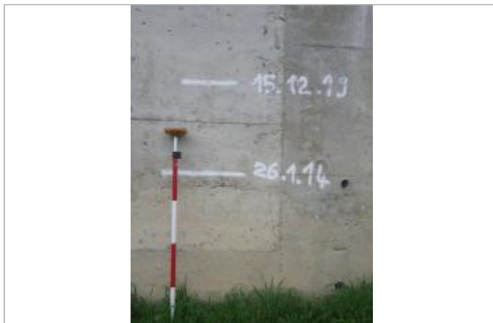
Berge rive droite - Photo ©AGERIN
