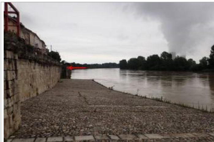
Escaliers quai Chauderon - Photo ©AGERIN
