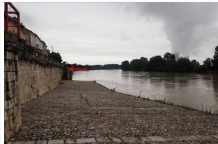
Escaliers quai Chauderon - Photo ©AGERIN
