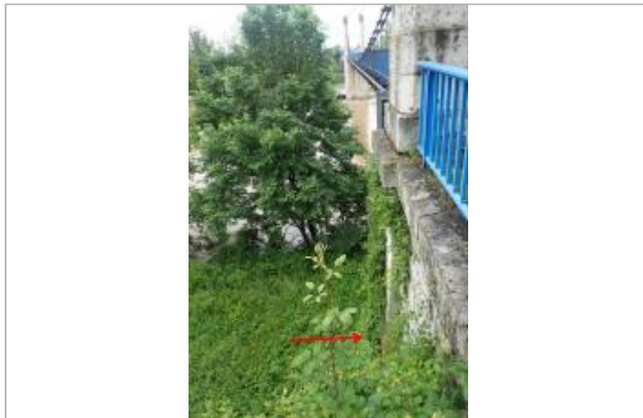
Pile rive droite du pont D308 - Photo ©AGERIN
