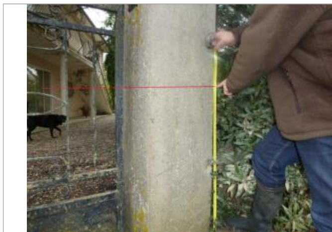
Trace muret portail - Photo ©DDT
