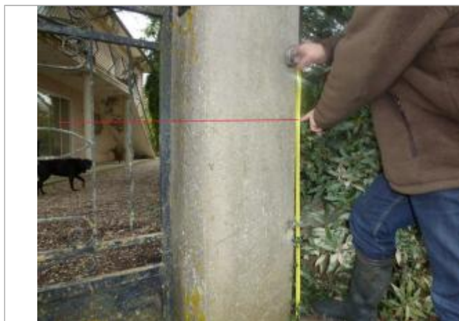
Trace muret portail - Photo © DDT
