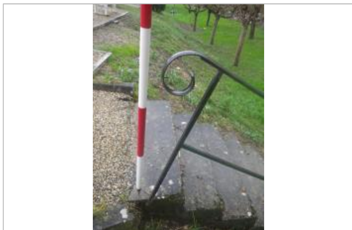
Trace béton sol - Photo ©AGERIN
