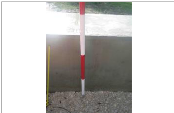
Mur digue quai de la Garonne - Photo ©AGERIN
