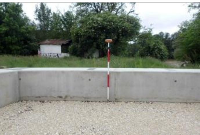
Laisse inondation sur le mur - Photo ©AGERIN
