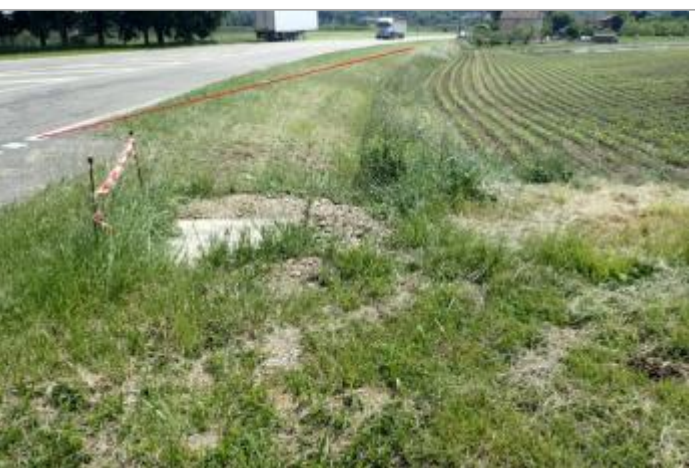
Débris végétaux au sol - Photo ©AGERIN
