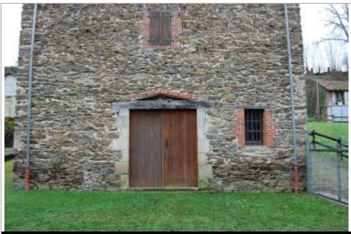
Vue du site - Auteur : GEOSPHAIR
