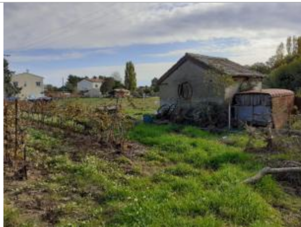
Vue du site
