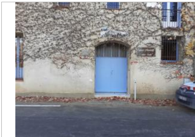
Vue du site
