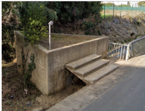
av puissalicon lieuran
