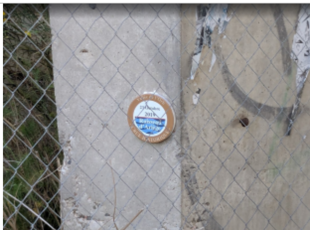
pilier pont A9
