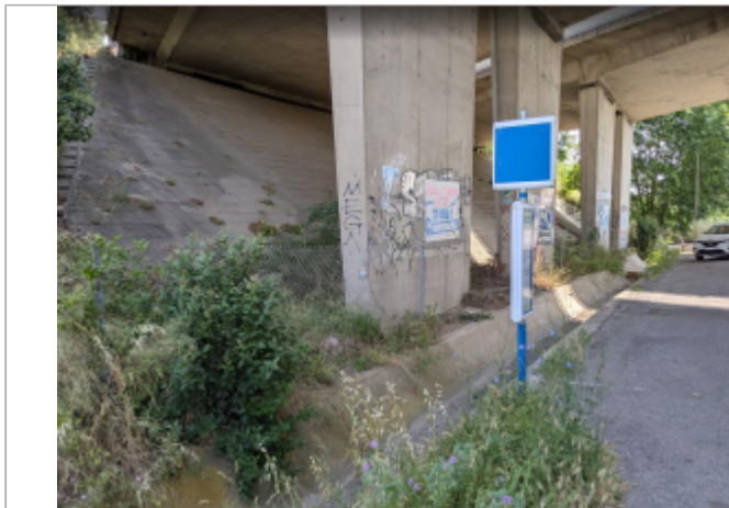
pilier pont A9
