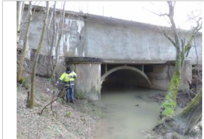
Aval pont canal des louvières
