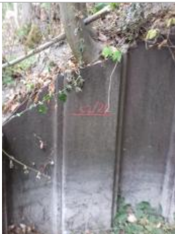
Retour pale planche, à l'aval du pont canal, rive droite
