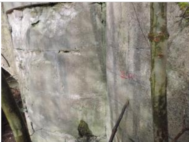
Amont pont canal, sur la culée du pont rive droite
