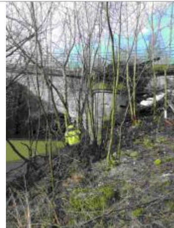
Amont pont canal des louvières
