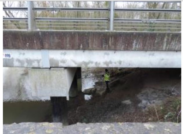
Pilier du pont amont sur la N44 en direction de Vitry-le-françois, RG
