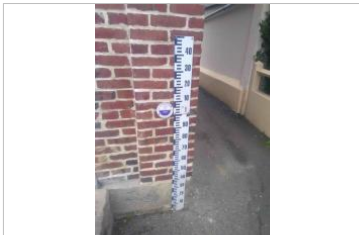
Vue large de l'échelle et du macaron (source : B2HPC SACN)
