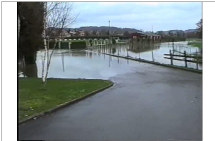
Site inondé en janvier 2003
