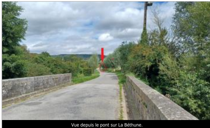
Vue depuis le pont sur La Béthune.
