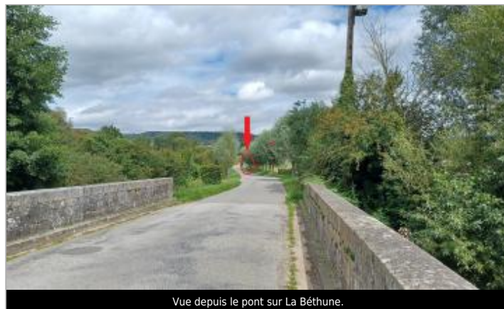
Vue depuis le pont sur La Béthune.
