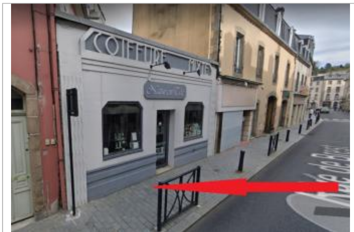
trottoir devant le n°23 rue de Brest
