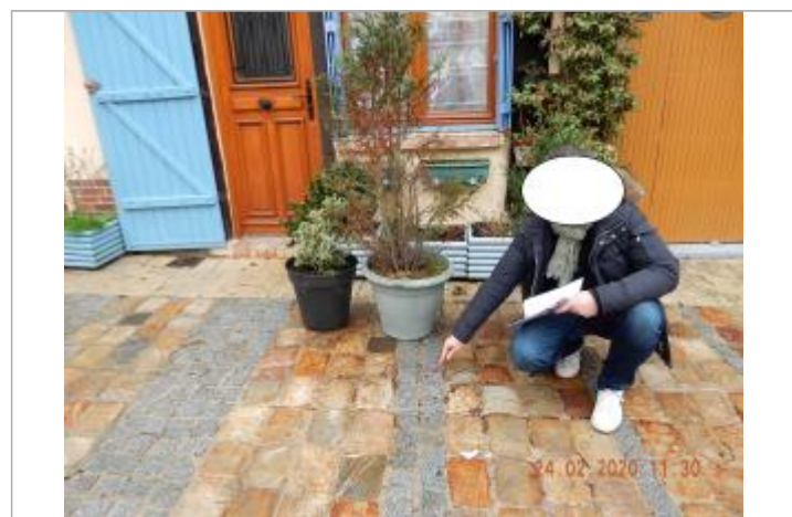
Laisse de crue au niveau de la 5 ème rangé de pavés gris en descendant la rue
