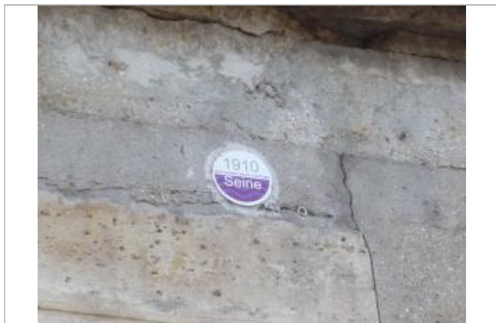
Repère de crue 100ale
