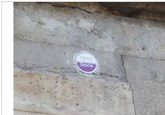
repère de crue posé par l'EPTB Seine Grands Lacs
