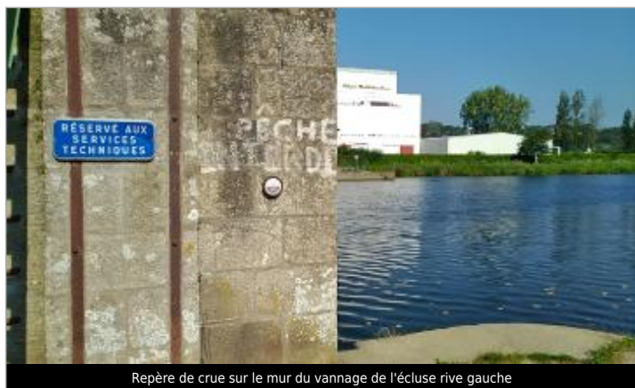
Repère de crue sur le mur du vannage de l'écluse rive gauche
