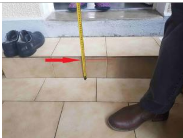
Laisse de crue au niveau du haut de la première marche dans la véranda à 15 cm/sol
