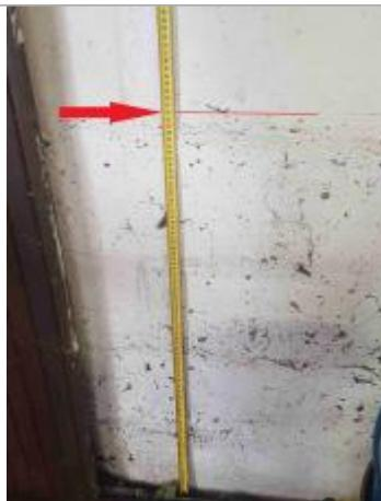
Laisse de crue sur mur du sous-sol à 92 cm/sol
