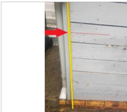
Laisse de crue sur le mur du garage à 95 cm/sol
