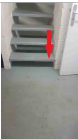
Laisse de crue au niveau supérieur de la première marche du sous sol
