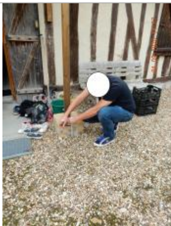
Laisse de crue à 17 cm au du sol au pied du pilier de la marquise.
