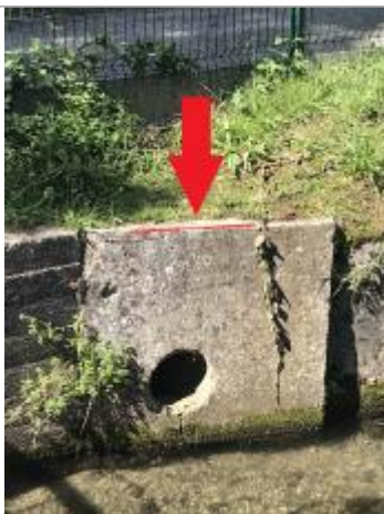
Laisse de crue au niveau du bord supérieur en ciment de la buse
