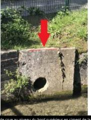
Laisse de crue au niveau du bord supérieur en ciment de la buse
