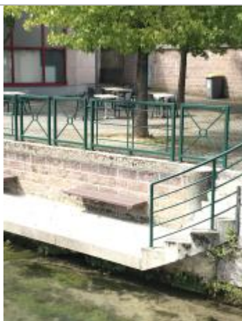
Vue sur le banc depuis le pont en amont (source : SPC SACN)
