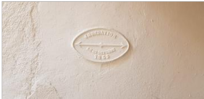
Repère de crue gravé sur la façade à l'intérieur de la cour (propriété privée)
