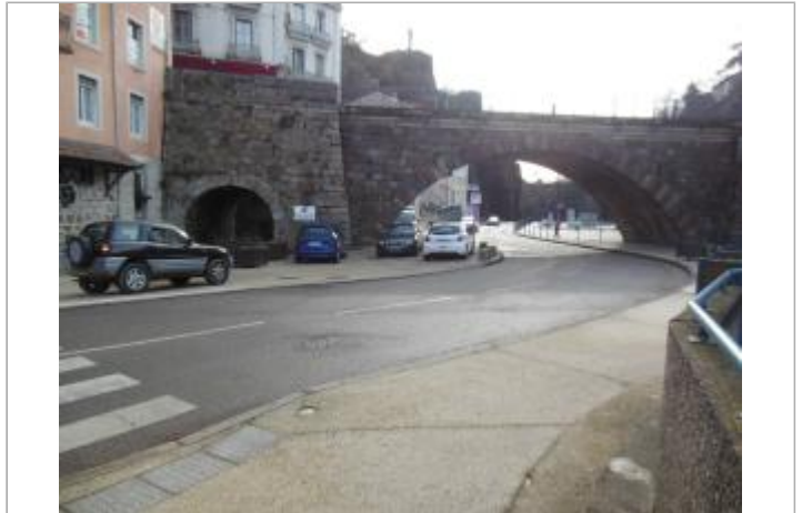
Pont Mongolfier - vue de la rive droite de la Deûme
