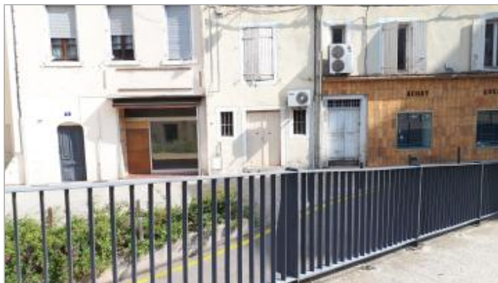
Vue du repère de crue (à gauche) de la rue piétonne le long de l'Avenue de l'Europe
