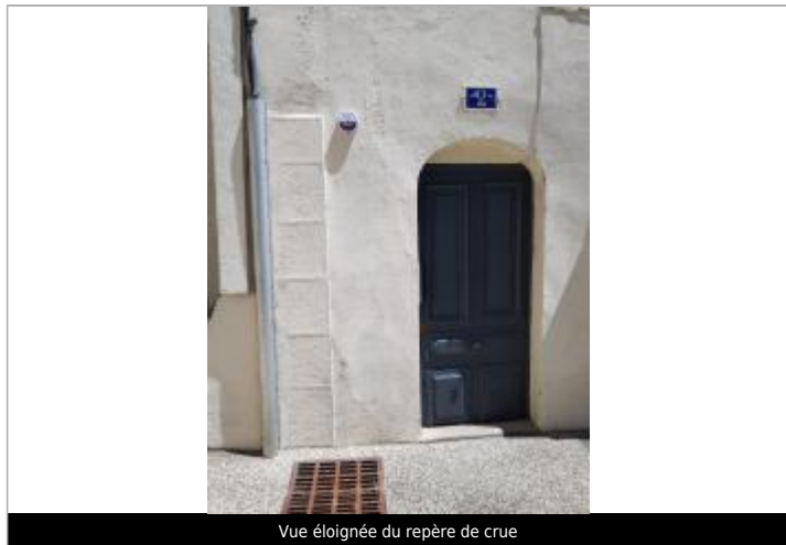
Vue éloignée du repère de crue
