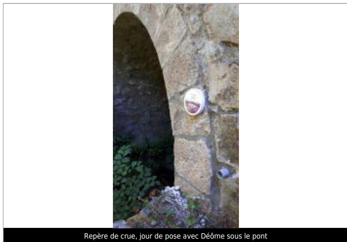
Repère de crue, jour de pose avec Déôme sous le pont
