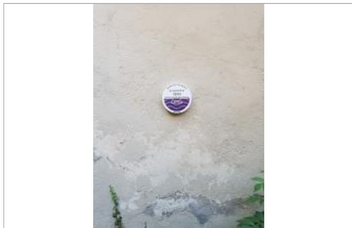
Repère de crue, jour de pose
