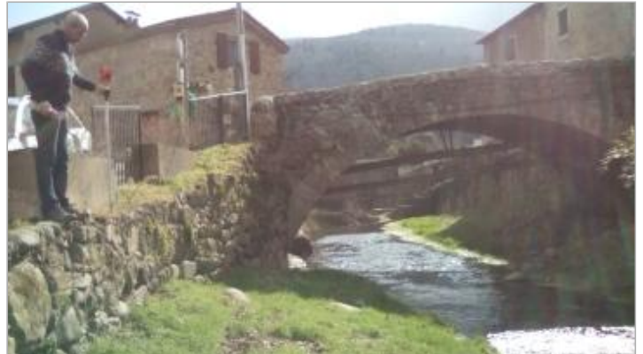
Le Vieux Pont - haut du mur en rive gauche nivelé à 429.03 m NGF
