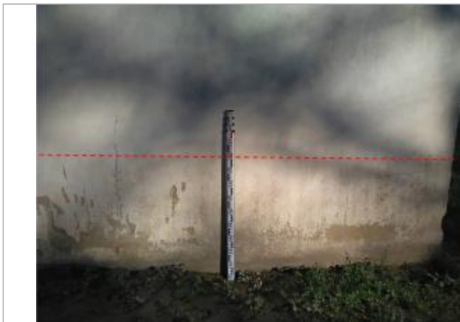
Laisse de crue sur le mur arrière de la station - Photo ©AGERIN
