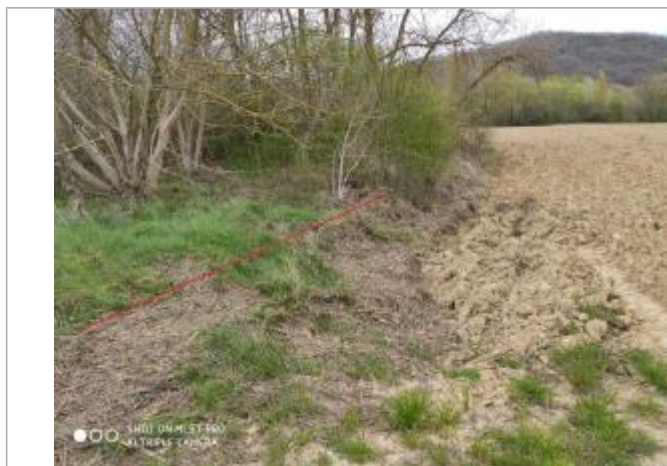
Débris végétaux au sol - Photo ©AGERIN
