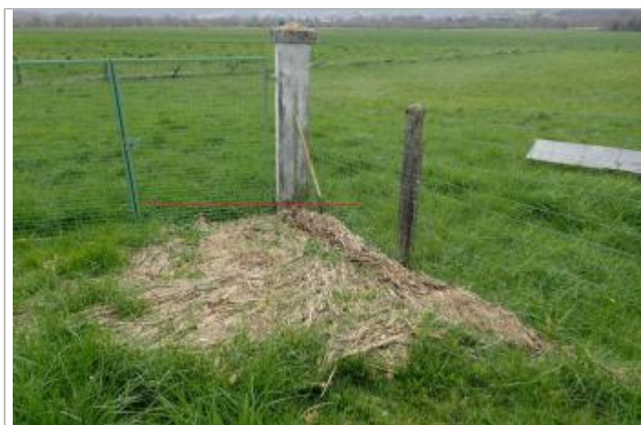
Portail de la station de pompage - Photo ©AGERIN
