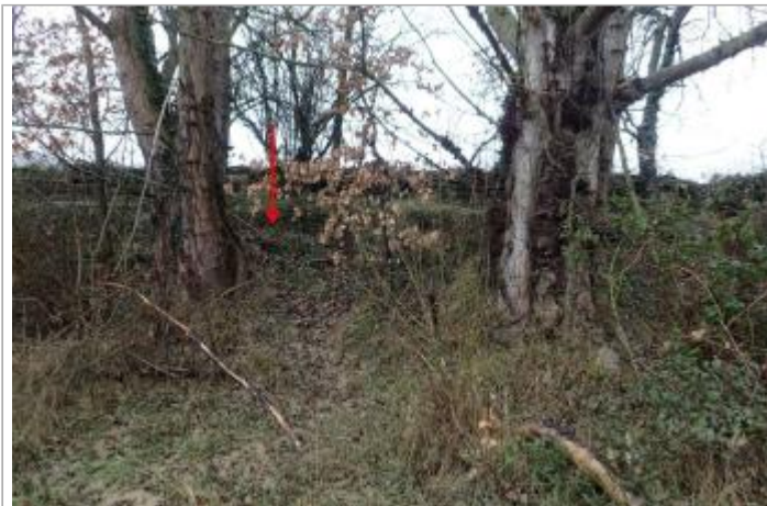
Digue proche de la station d'épuration de camp Limoux - Photo ©AGERIN
