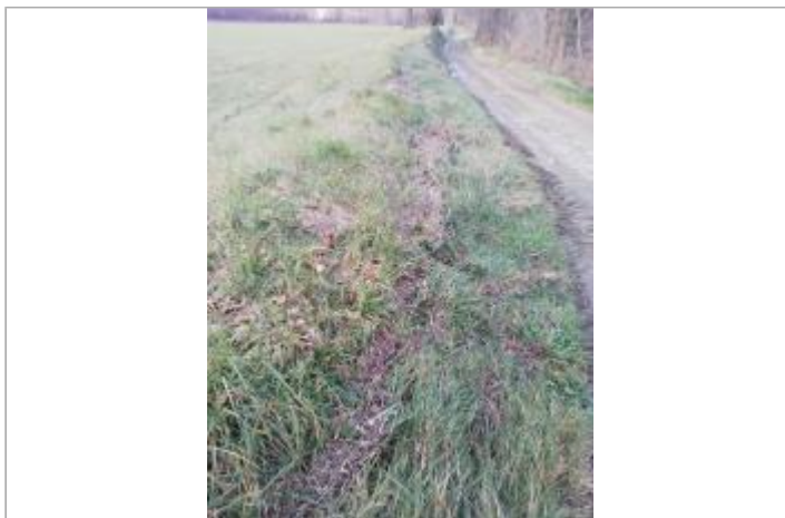
Digue au bord du chemin - Photo ©AGERIN
