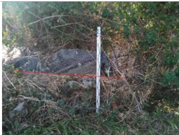
Grillage bord de l'Hers en rive droite - Photo ©AGERIN
