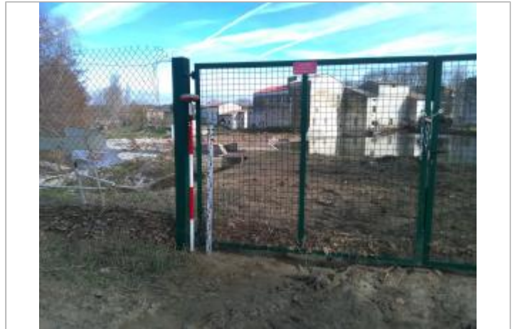
Portail d'accès au seuil de Moulin-Neuf - Photo ©AGERIN
