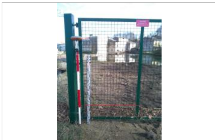
Laisse de crue sur le portail - Photo ©AGERIN
