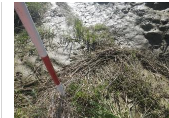
Débris végétaux au sol - Photo ©AGERIN
