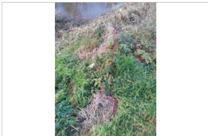
Débris végétaux en haut de berge - Photo ©AGERIN
