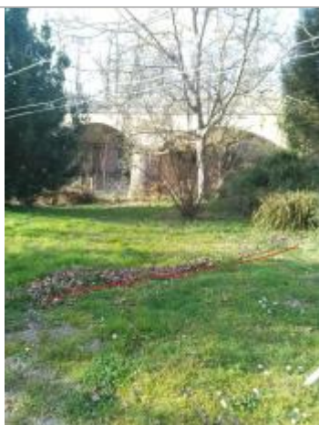
Débris végétaux au sol - Photo ©AGERIN
