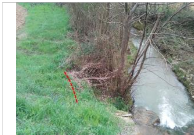
Débris végétaux en haut de berge - Photo ©AGERIN
