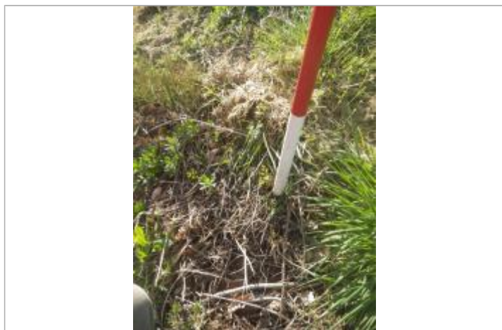
Débris végétaux haut du talus - Photo ©AGERIN
